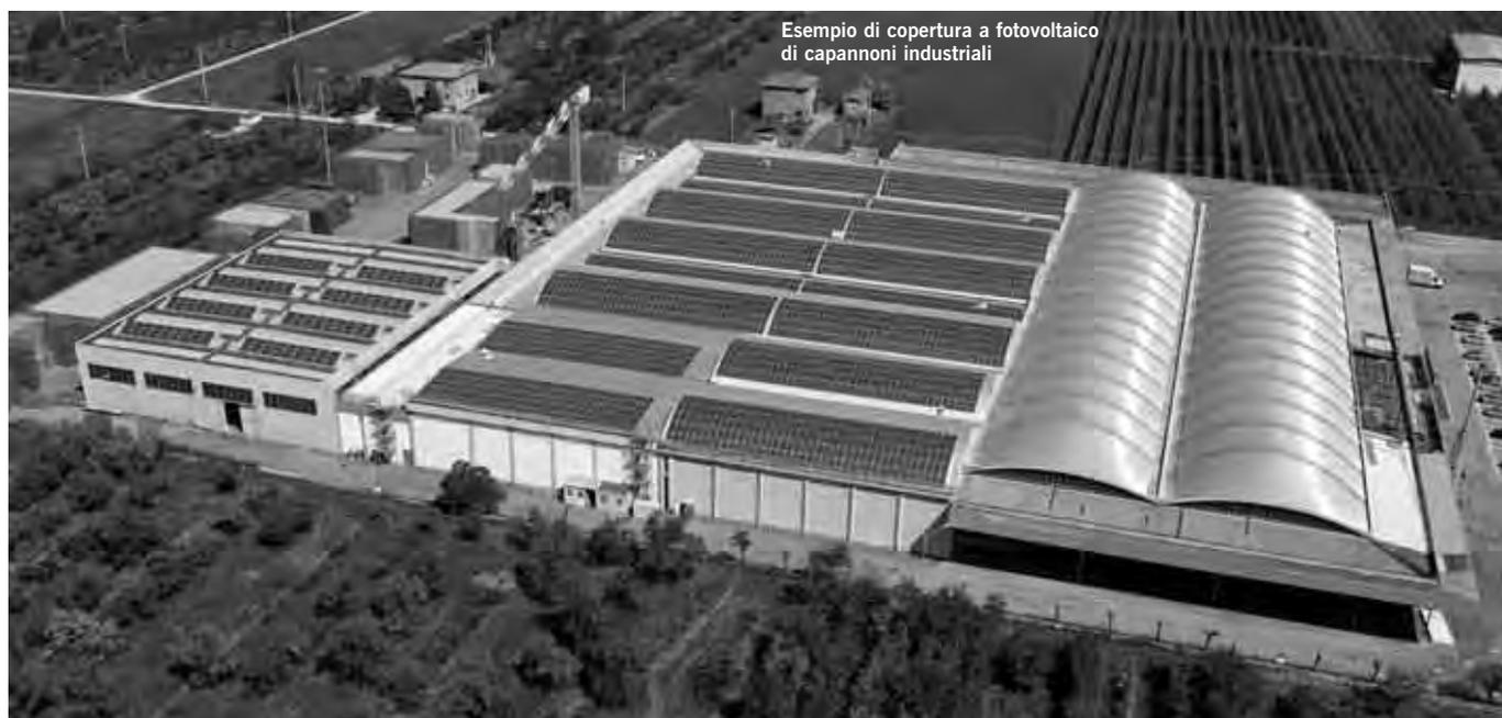
Esempio di copertura a fotovoltaico di capannoni industriali
